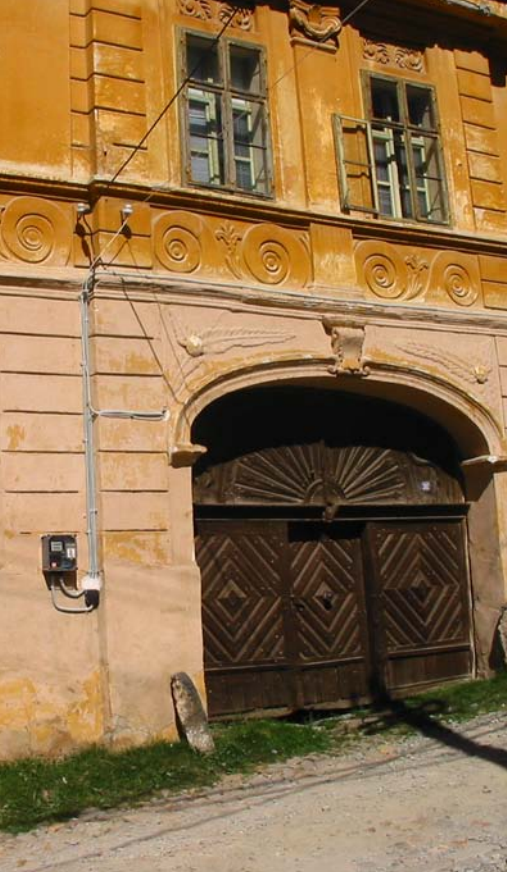
Strada Brazi (Strada Siciliană)
