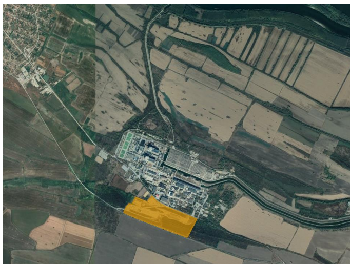
Figură 4 – Șantierul CNE „Kozloduy“ și șantierul DNÎDAJMVS „Radiana“ (conturată în portocalie)
