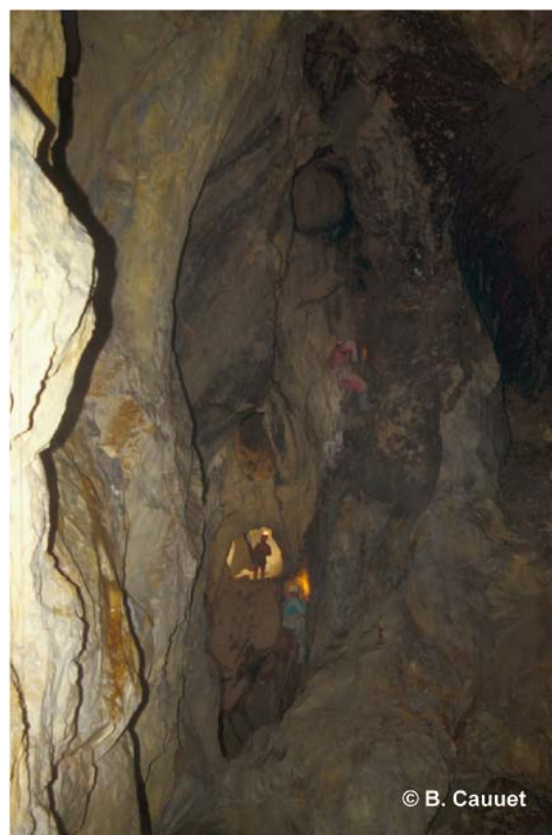
Piatra Corbului – lucrări miniere subterane de epocă romană produse prin utilizarea focului
