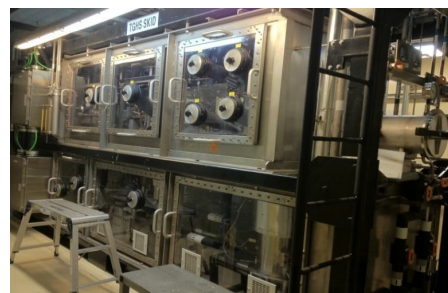
Fig. III.5-6 Sistemul de manipulare și stocare tritiu gaz de la WTRF-Coreea
