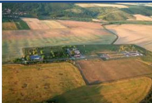
Unitatea de Stocare și de Prelucrare a Deșeurilor Radioactive (Püspökszilágy)
