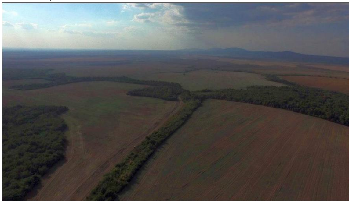
Fig. 27 Aspect din partea de nord a Potoc 4, arealul turbinei 7P4.
