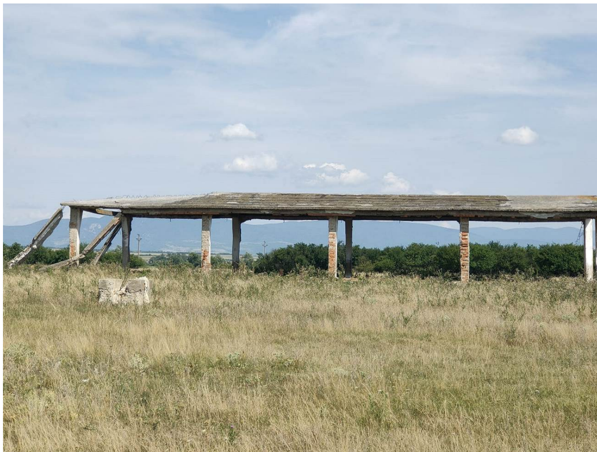
Fotografia 18: Clădire abandonată potențial optimă pentru specii de crăpătură – Potoc 3
