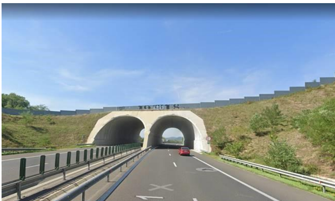
Figura nr. 3-17 Ecoductele construite pentru supratraversarea autostrăzii Lugoj – Deva (sursa: economedia.ro, Google Street View)
