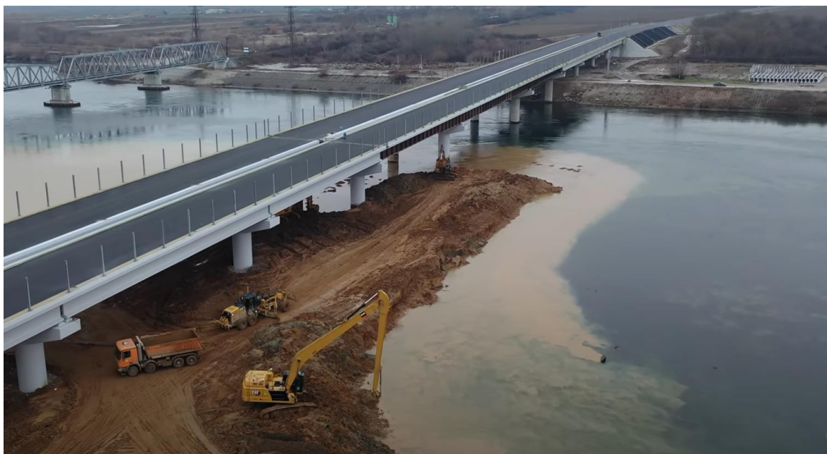
Figura nr. 3-40 Lucrări temporare în albie la construcția unei infrastructuri rutiere noi. Acestea produc modificări temporare atât la nivelul substratului cât și al parametrilor fizico-chimici ai corpului de apă
